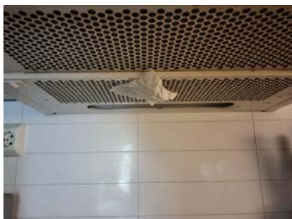
Avtrekkseffekt er testet med papir.
