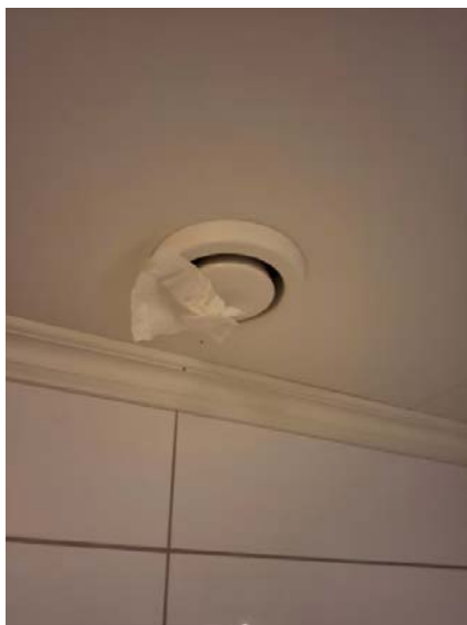
Avtrekkseffekten er testet med papir.
