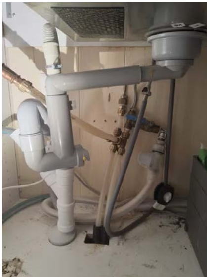
Leiligheten har synlige avløpsrør av plast.
