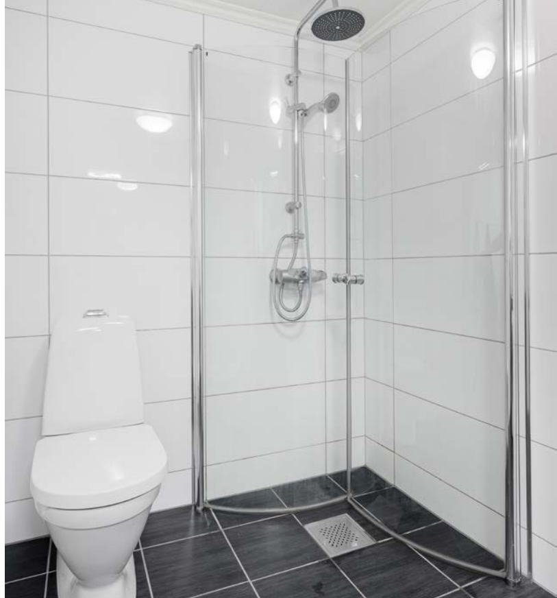
Gulvmontert toalett og dusjhjørne med innfellbare dører og veggmontert dusjbatteri med regnfall.
