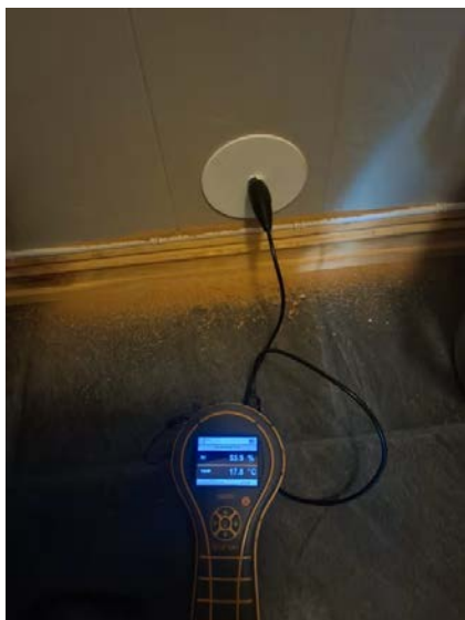
Bilde fra fuktmåling i utlektet veggkonstruksjon
