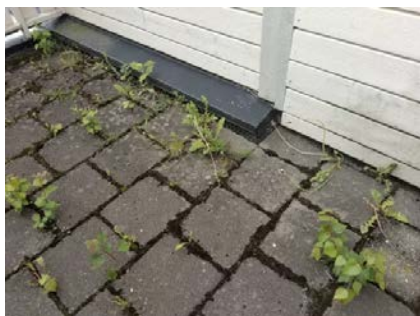
Det registreres synlig fuktsperre mot grunnmur.
