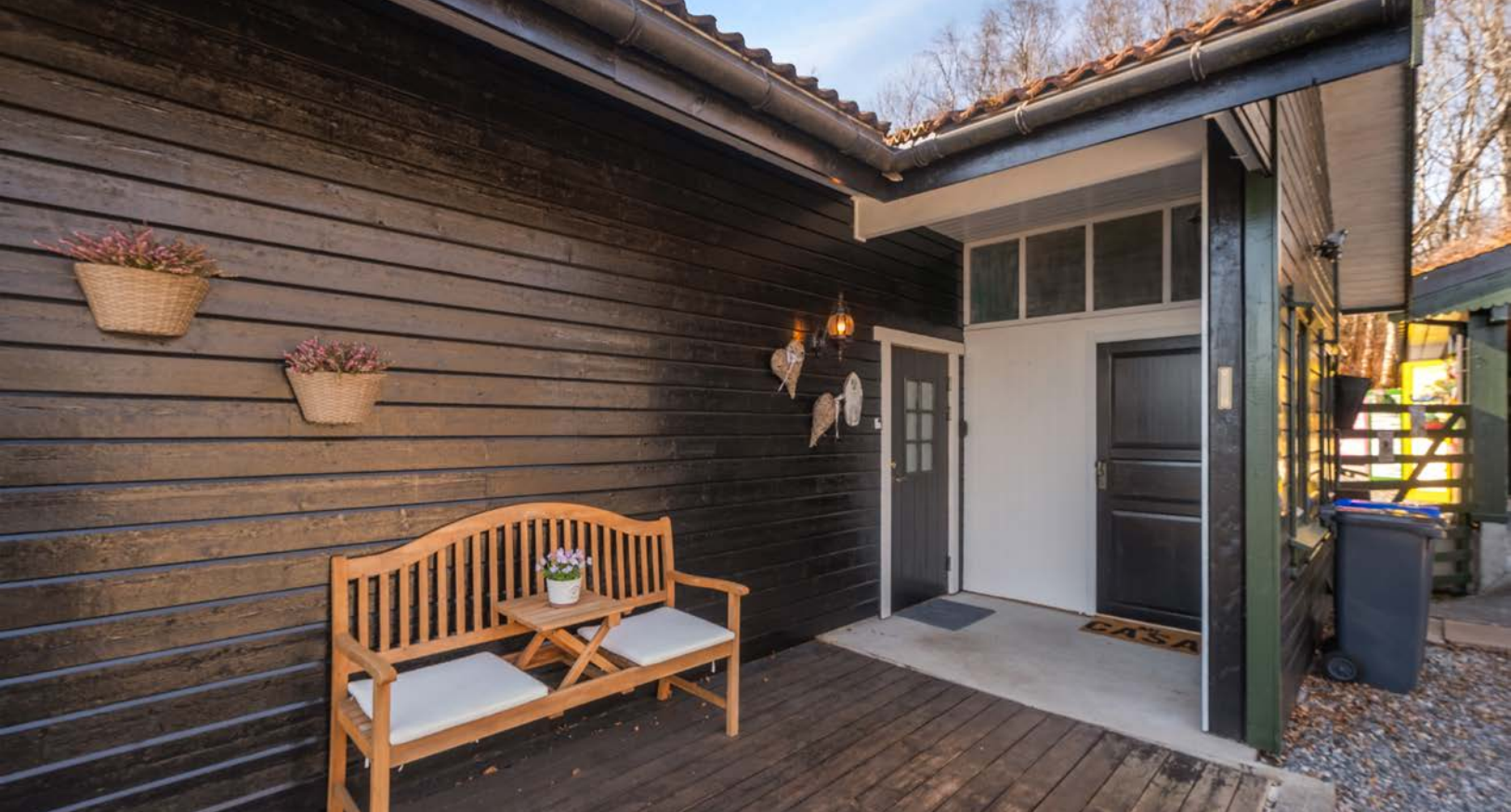
Inngangsparti med deler av terrassen som strekker seg rundt boligen.
