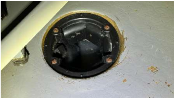
Kontroll av sluk.
