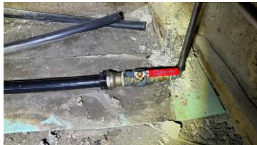
Kontroll av hovedstoppekran.
