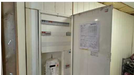
Kontroll av el-skap og kursfortegnelse.
