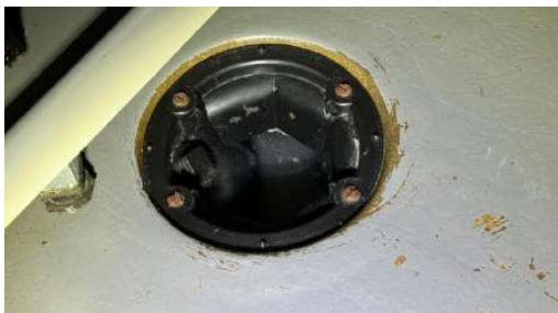
Kontroll av sluk.
