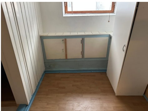
Fuktkontroll er foretatt i luke i vegg der hovedstoppekranen er.
