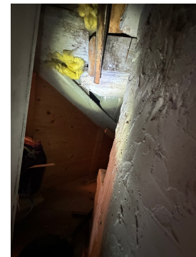
Bilde av takkonstruksjonen tatt ved pipe på loft.
