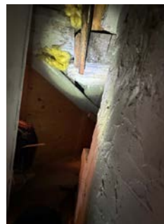
Bilde av takkonstruksjonen tatt ved pipe på loft.
