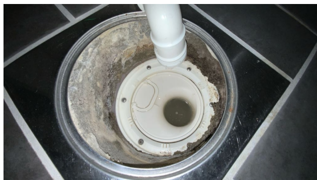
Kontroll av sluk.
