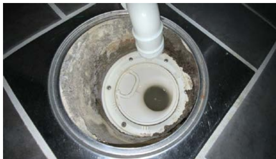
Kontroll av sluk.
