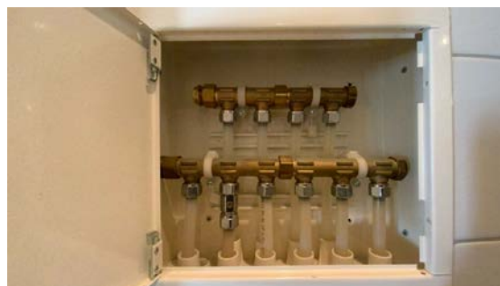
Besiktigelse av røropplegg.
