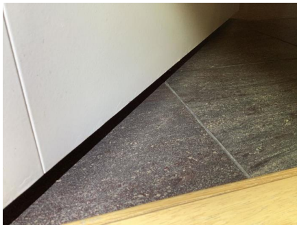
Antydning til svelling på dørbblad i våtsone.
