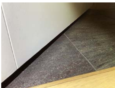
Antydning til svelling på dørblad i våtsone.
