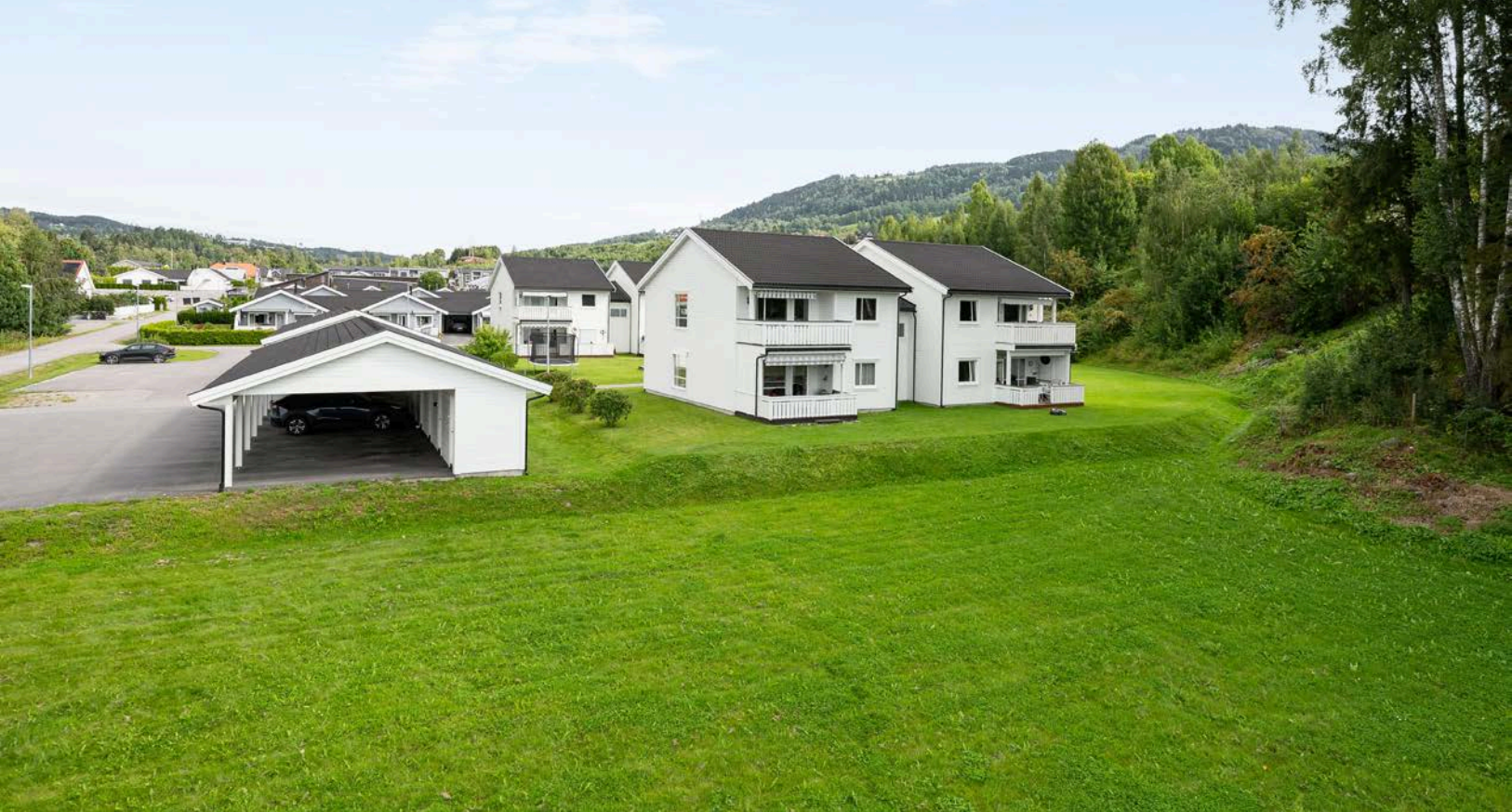
Felles carportanlegg og gjesteparkering til venstre. Stort grøntområde foran byggene.
