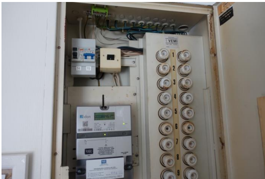
Bildet viser skrusikringer
