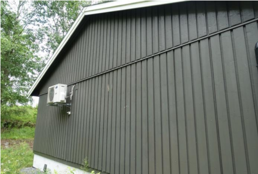
Bildet viser utvendig kledning.
