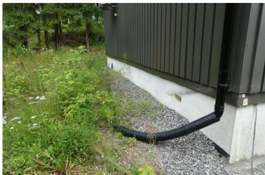
Bildet viser skiftet drenering høsten 2021
