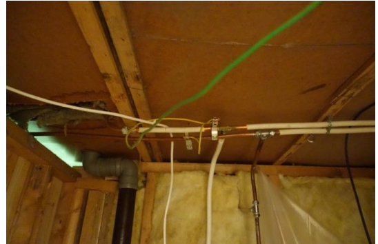
Bildet viser etasjeskiller under kjøkken
