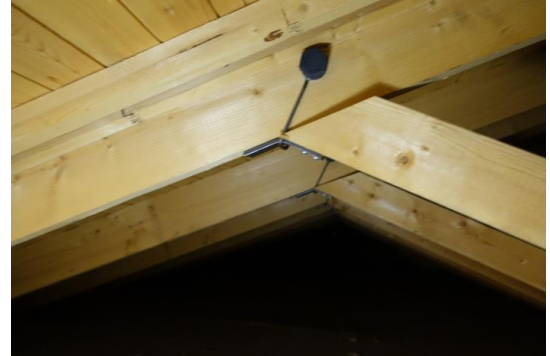
Bildet viser detaljer av takkonstruksjon
