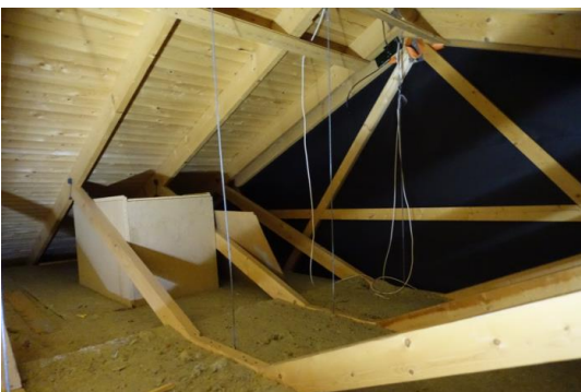
Bildet viser isolert takkonstruksjon
