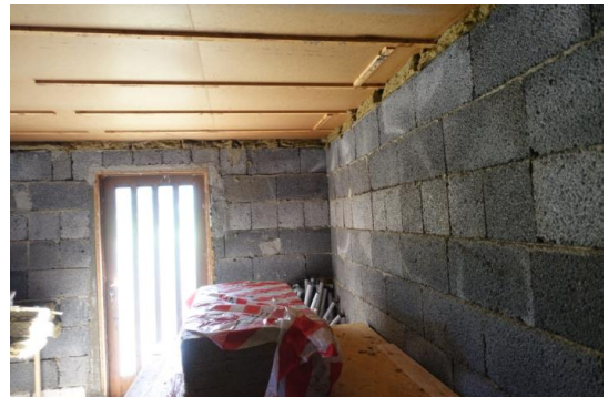
Bildet viser uinnredet kjellerrom
