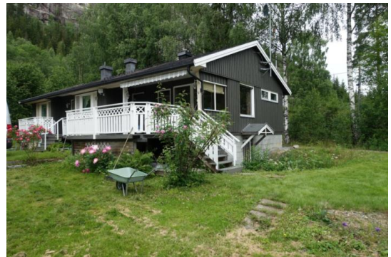
Bildet viser deler av rekkverk på veranda, reparert og skiftet råteskader i rekkverk
