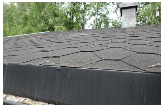
Bildet viser takfotbeslag
