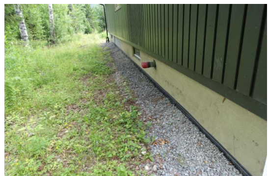
Skiftet drenering høsten 2021
