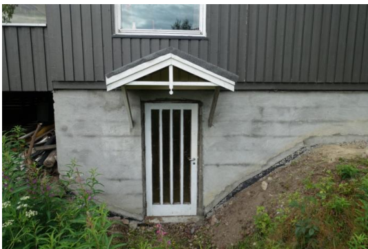
Bildet viser dør inn i kjellerom, uinnredet
