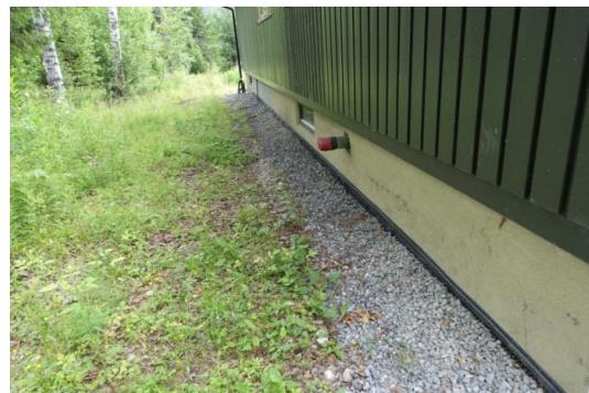
Bildet viser utvendig terrengforhold
