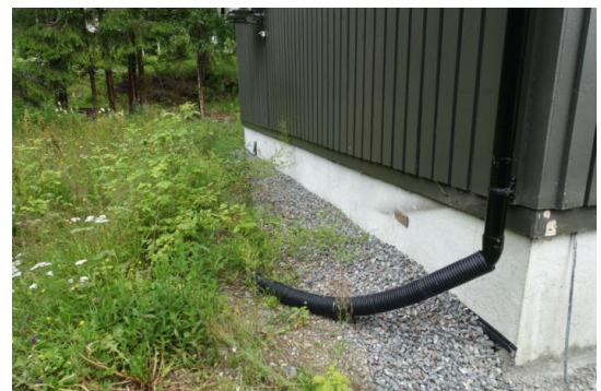
Viser utkast av takrenne nedløp.
