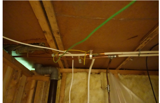
Bildet viser etasjeskiller under kjøkken
