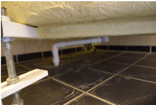
Bildet viser avløp fra dusjkabinett direkte ned i sluk
