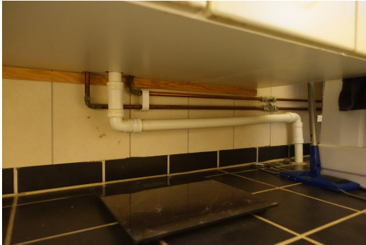
Bildet viser utenpåliggende rør på badetrom
