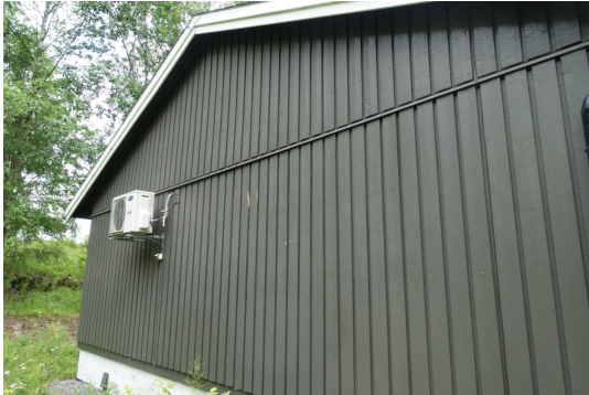
Bildet viser utvendig kledning.
