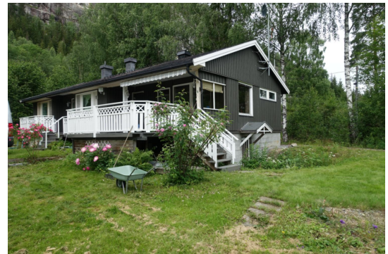
Bildet viser deler av rekkverk på veranda, reparert og skiftet råteskader i rekkverk
