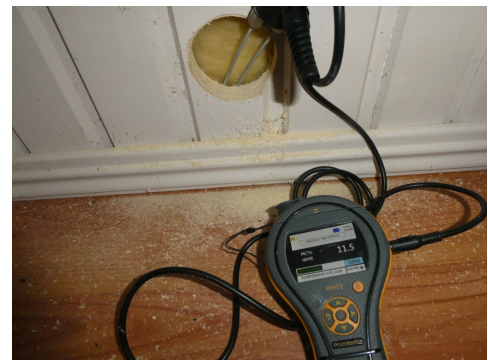
Ingen unormale fuktverdier ved hulltaking på vegg under terreng, soverom i kjeller.
