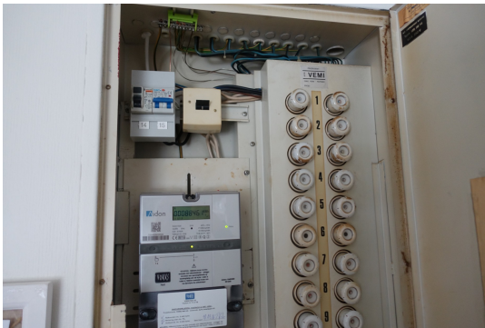
Bildet viser skrusikringer
