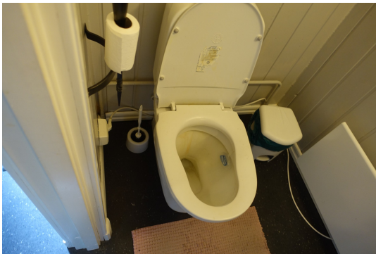
Bildet viser gulvmontert wc på toalettrom.
