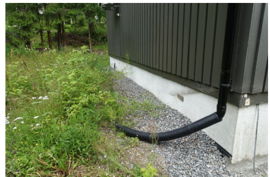
Viser utkast av takrenne nedløp.
