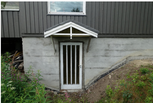
Bildet viser dør inn i kjellerom, uinnredet
