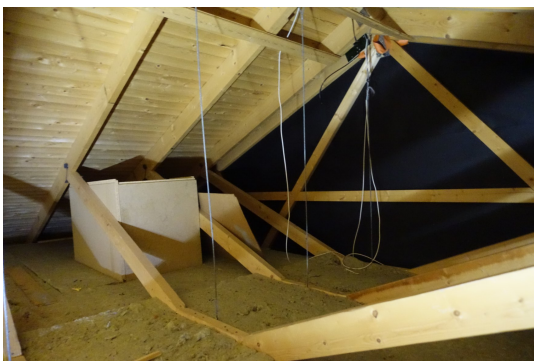
Bildet viser isolert takkonstruksjon
