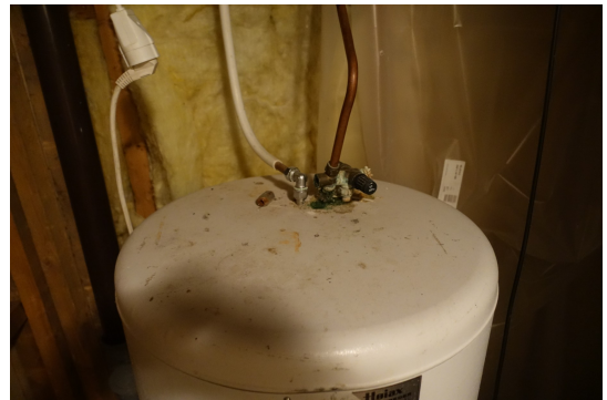
Bildet viser røropplegg
