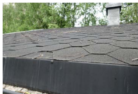
Bildet viser takfotbeslag
