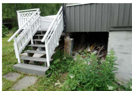
Bildet viser trapp fra veranda.
