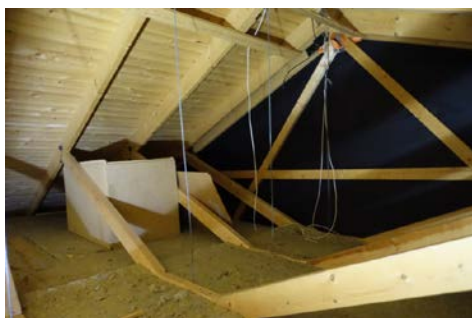
Bildet viser isolert takkonstruksjon
