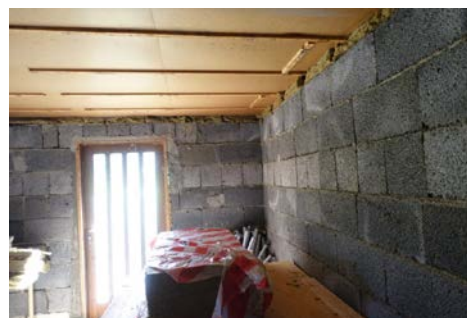
Bildet viser uinnredet kjellerrom
