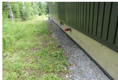
Bildet viser utvendig terrengforhold
