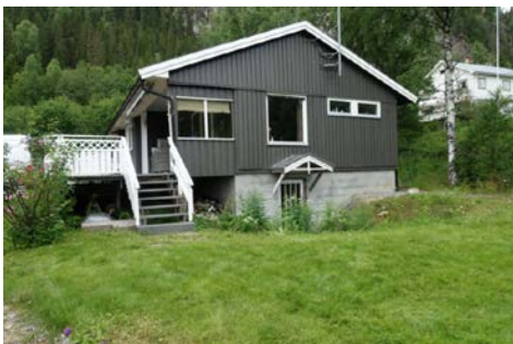
Bildet viser utvendige terrengforhold
