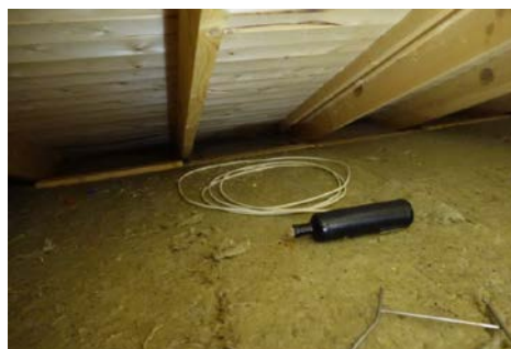
Bildet viser konstruksjon.
