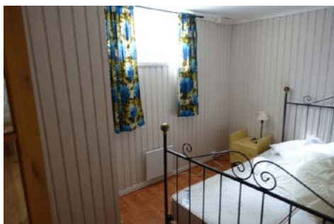
Bildet viser trepanel, malt på soverom. Bildet viser etablert ikke godkjent soverom i kjeller etasje.
