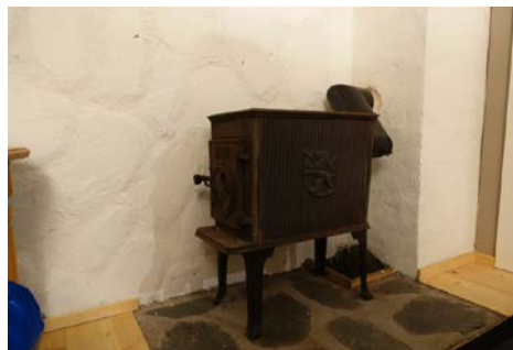
Bildet viser vedovn i kjellerrom
