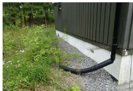
Viser utkast av takrenne nedløp.
