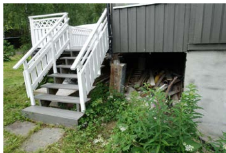
Bildet viser trapp fra veranda
