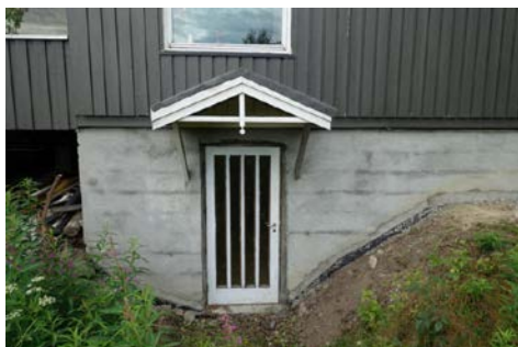
Bildet viser dør inn i kjellerrom, uinnredet
