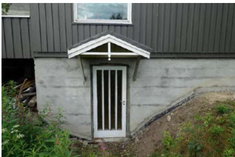
Bildet viser utvendige terrengforhold inngang til uinnredet kjellerrom
