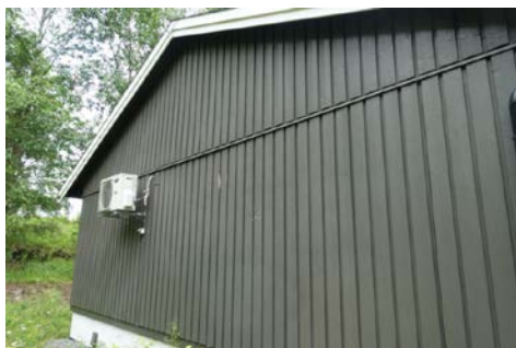
Bildet viser utvendig kledning.
