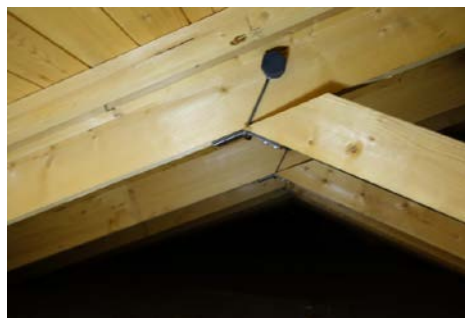
Bildet viser detaljer av takkonstruksjon
