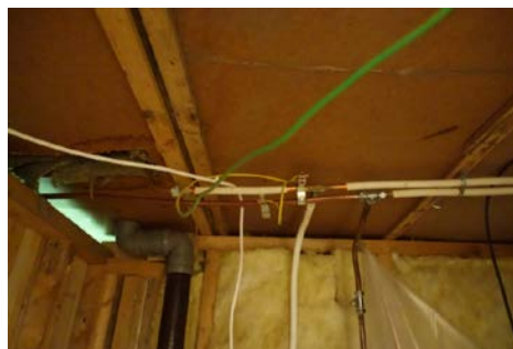
Bildet viser etasjeskiller under kjøkken
