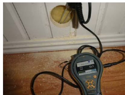
Ingen unormale fuktverdier ved hulltaking på vegg under terreng, soverom i kjeller.
