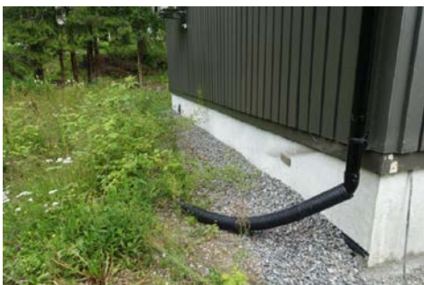
Bildet viser skiftet drenering høsten 2021
