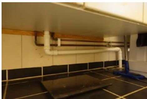
Bildet viser utenpåliggende rør på badetrom
