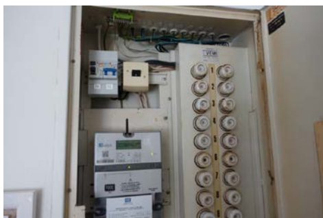
Bildet viser skrusikringer
