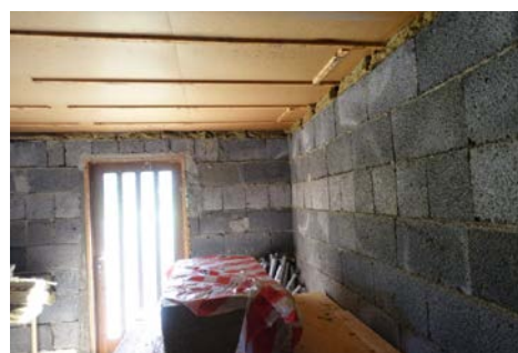
Bildet viser uinnredet kjellerrom
