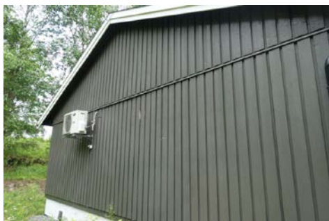
Bildet viser utvendig kledning.
