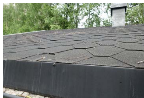
Bildet viser takfotbeslag
