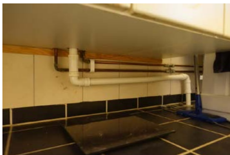
Bildet viser utenpåliggende rør på badetrom
