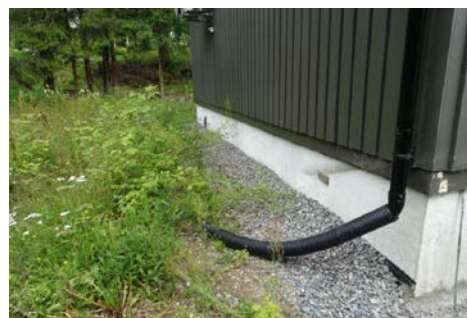
Viser utkast av takrenne nedløp.
