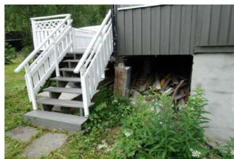
Bildet viser trapp fra veranda.
