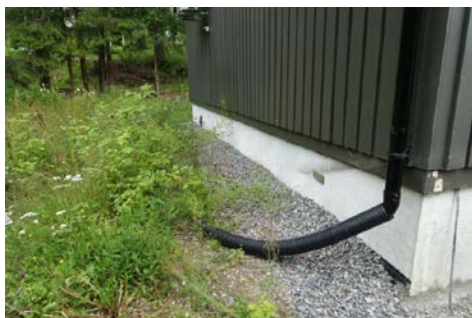
Bildet viser skiftet drenering høsten 2021
