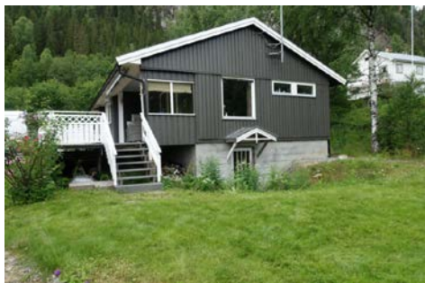
Bildet viser utvendige terrengforhold
