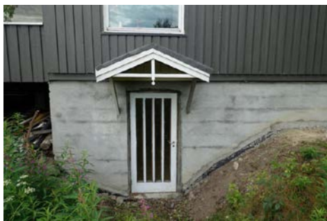
Bildet viser dør inn i kjellerom, uinnredet
