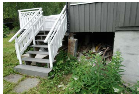
Bildet viser trapp fra veranda
