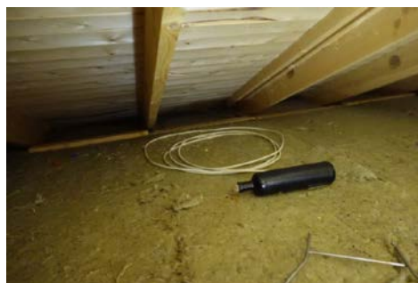
Bildet viser konstruksjon.
