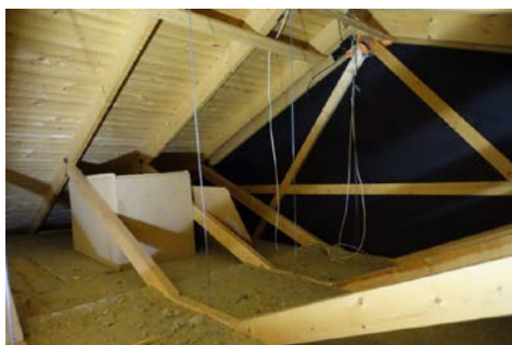
Bildet viser isolert takkonstruksjon
