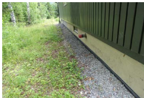
Bildet viser utvendig terrengforhold
