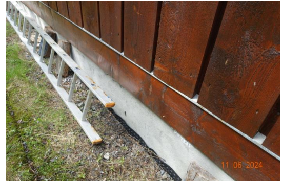
Grunnmur av Leca med puss.
