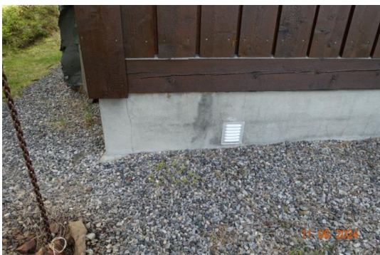
Grunnmur av Leca med puss.
