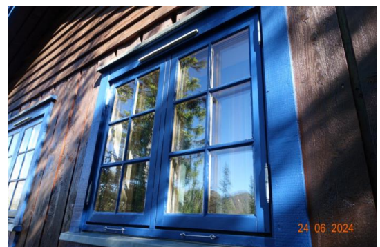
Vinduer av koblet vindu med 2-lag + smårutet glass.
