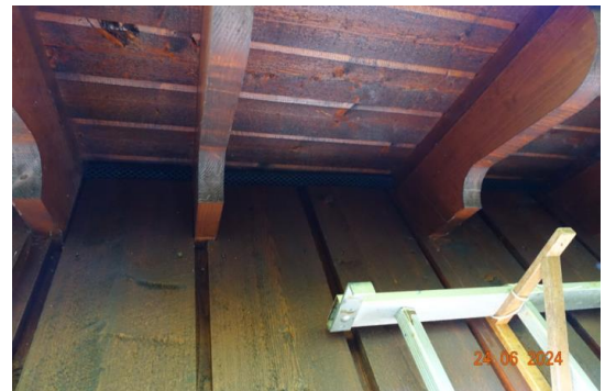
Takkonstruksjon med luftespalte.
