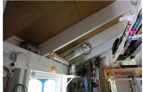
Takkonstruksjon fra innvendig bod.
