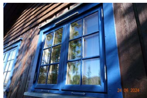
Vinduer av koblet vindu med 2-lag + smårutet glass.
