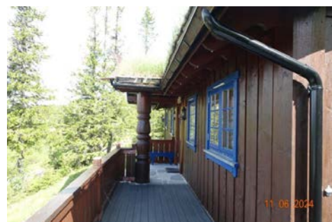
Nedløp av nedløpsrør.
