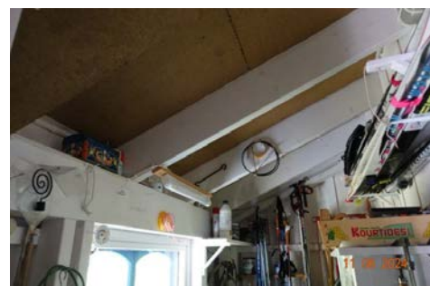
Takkonstruksjon fra innvendig bod.
