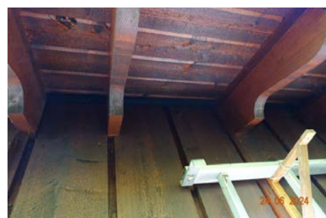
Takkonstruksjon med luftespalte.
