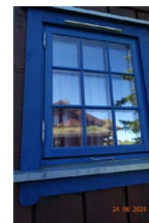
Vinduer av koblet vindu med 2-lag + smårutet glass.
