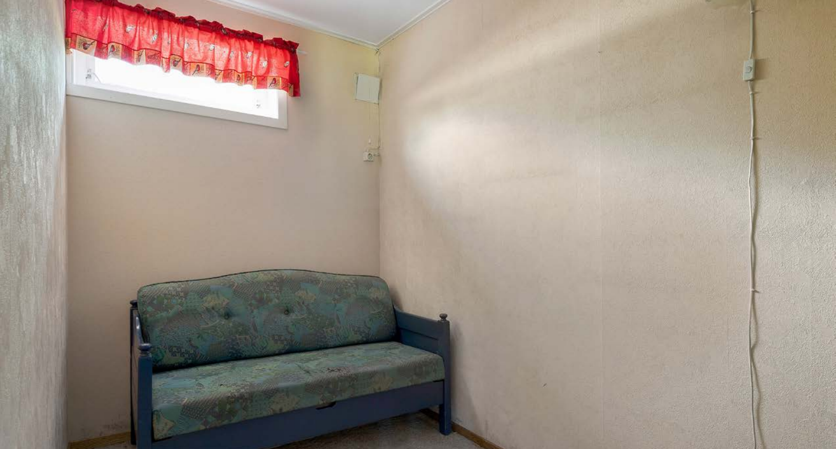
Dette rommet i hybelen er ikke godkjent som soverom.
