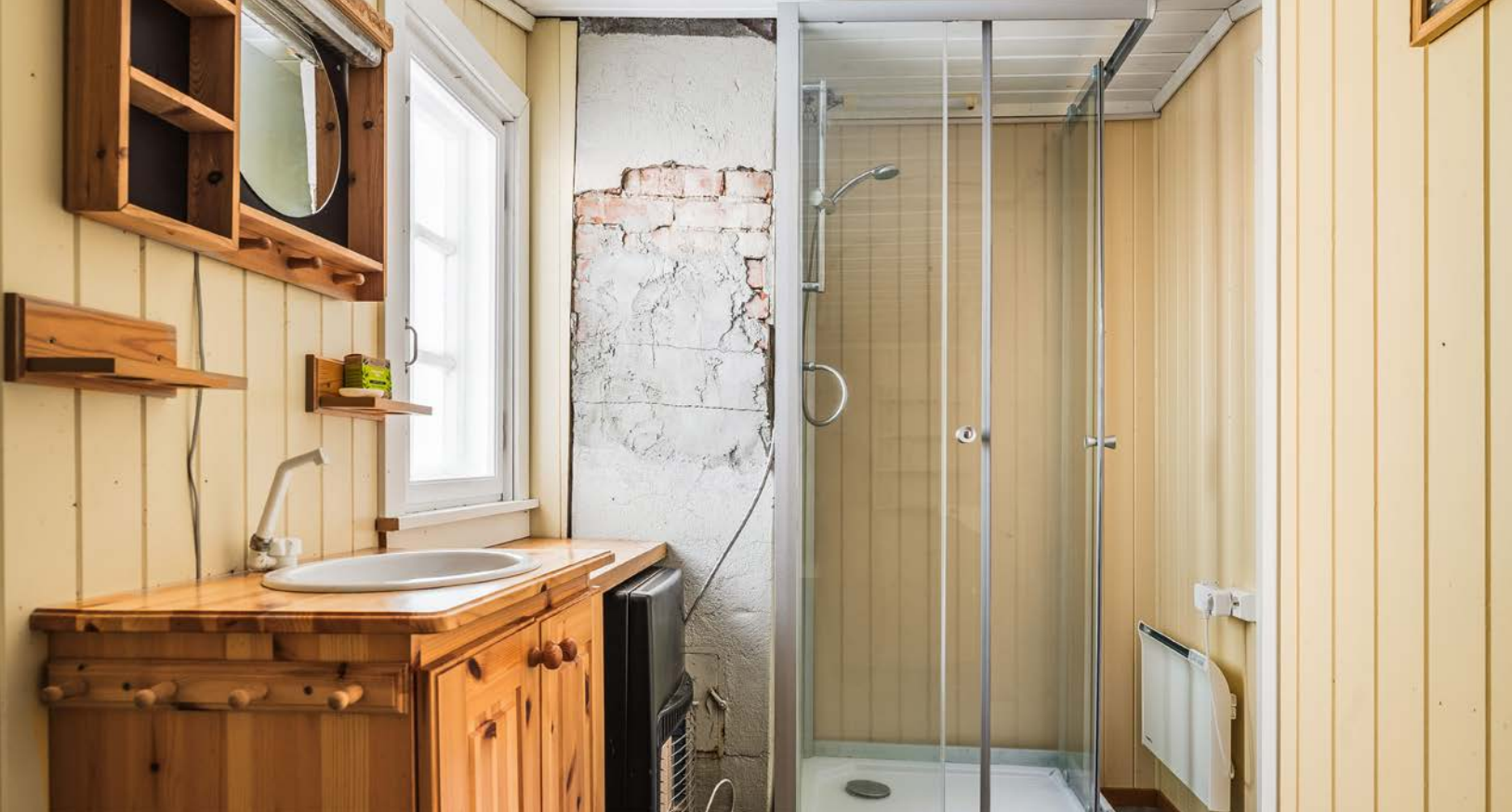
Installert innredning med servant og dusjkabinett. Vann fra bøtte med pumpe og avløp til terreng. Det er montert lys i dusjkabinett fra solcelleanlegget.
