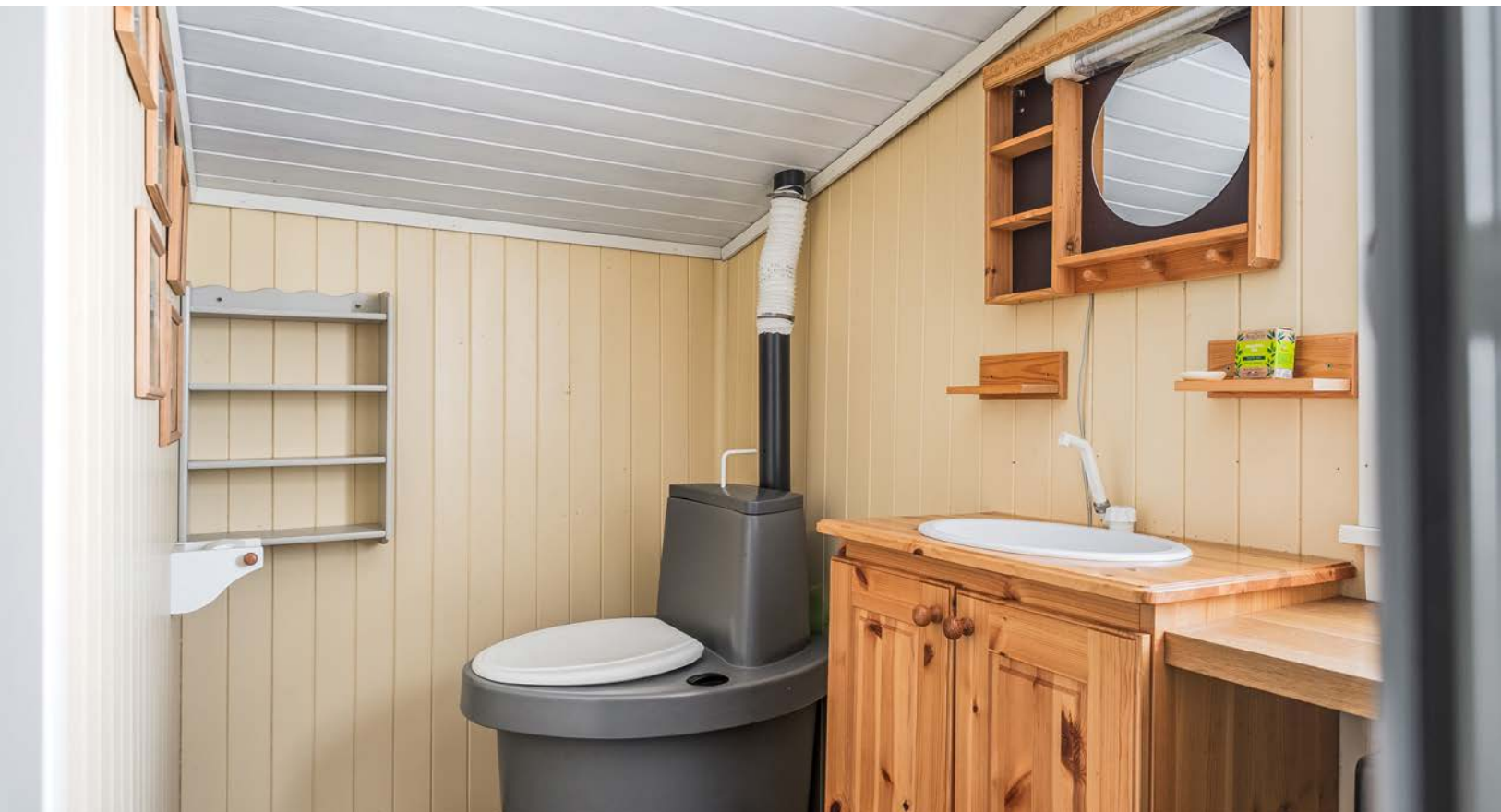
Rommet er også utstyrt med tørrklosset med lufting over tak.
