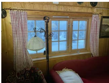
Vindu i stue.
