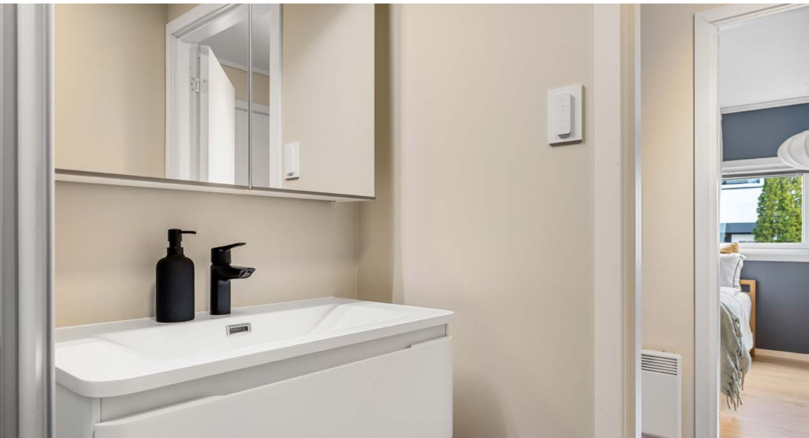
Lyst og pent baderom som ble modernisert i 2024. Badet har eldre våtromsbelegg på gulv som ble malt med 3 stjerner våtromsmaling i 2024 og nye gipsplater fra 2024 på veggene som ble malt med våtromsmaling.
