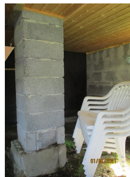
Pipe i kjeller med sotluke, ikke pussa
