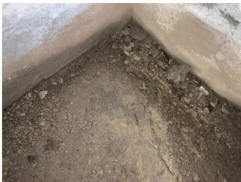
Vannsig fra sprekker i fjell
