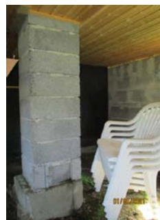
Pipe i kjeller med sotluke, ikkje pussa
