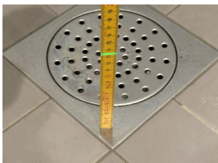
Fallforhold ca. 135 mm topp slukrist i dusjsone
