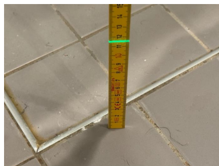
Fallforhold ca. 115 mm overkant gulv ved dusjsone
