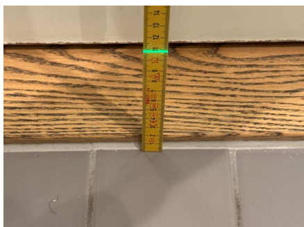
Fallforhold ca. 108 mm overkant gulv ved terskel
