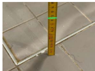
Fallforhold ca. 115 mm overkant gulv ved dusjsone
