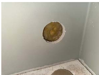
Hulltaking i tilstøtende soverom
