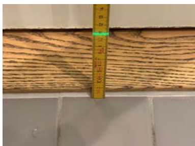
Fallforhold ca. 108 mm overkant gulv ved terskel
