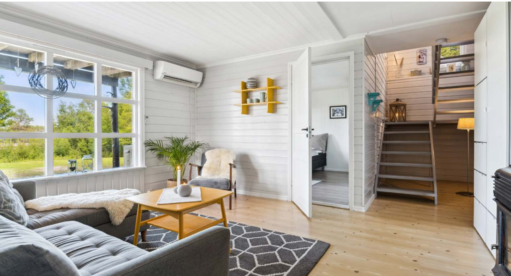
Kjellerstue med varmepumpe og vedovn som oppvarmingskilde.
