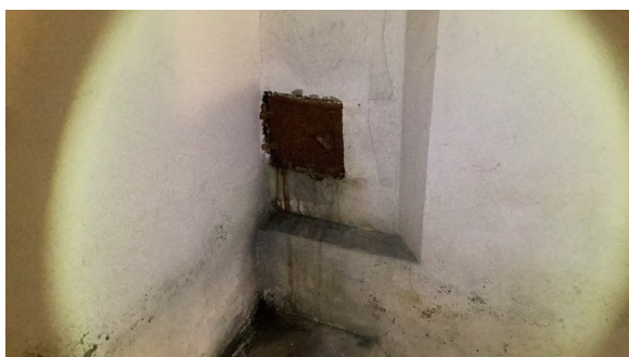
Sotluke i kjeller.
