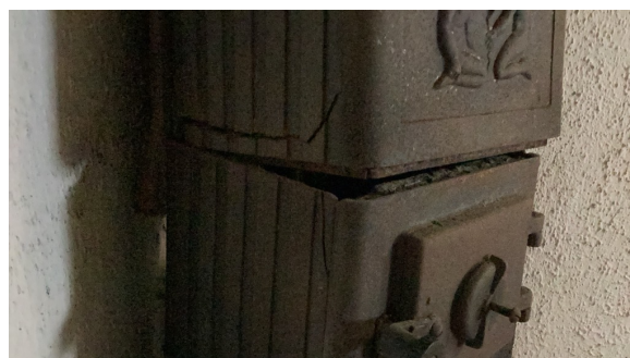
Skjevhet og utetthet på vedovn i kjeller.
