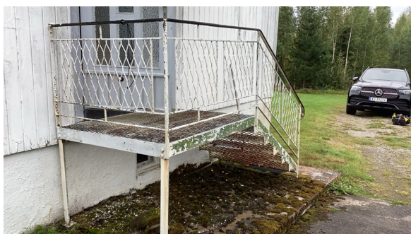
Trapp ved entre.
