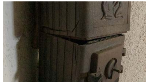
Skjevhet og utetthet på vedovn i kjeller.
