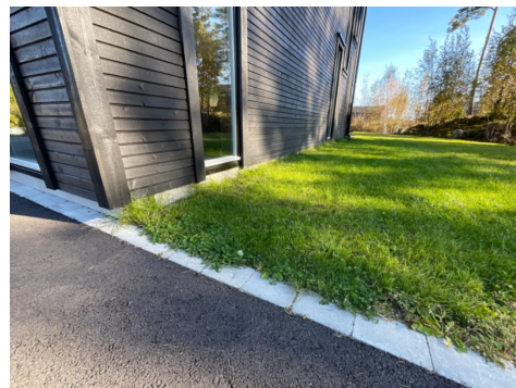
Kledning mot terreng
