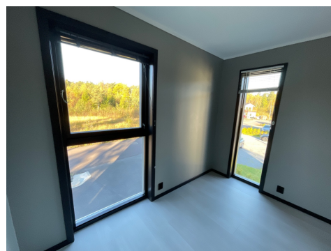
Vindu på soverom 2. etasje m/sidehengsling.
