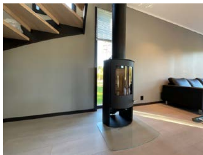
Pipe og ovn i stuen
