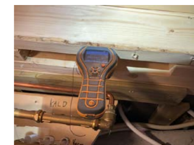
Enkel fuktmåling i etasjeskiller teknisk brønn viste tørre verdier.
