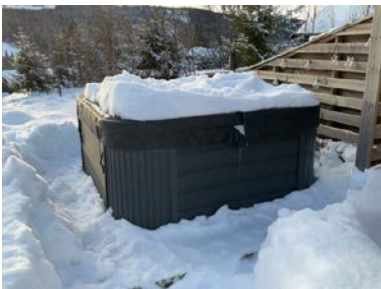
Jacuzzi på eiendommen. Installasjonen er ikke tilstandsvurdert.
