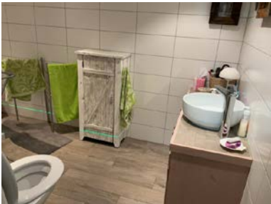
Oversiktsbilde av bad.
