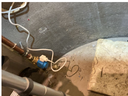
Hovedstoppekran og vannstoppeventil i teknisk brønn under hytta.
