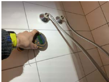
Enkle fuktsøk viste ingen unormale verdier.
