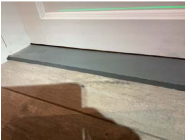
Tilluftsspalte under dør er ikke tilstrekkelig stor.
