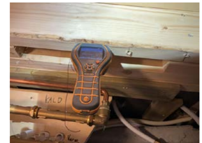
Enkel fuktmåling i etasjeskiller teknisk brønn viste tørre verdier.
