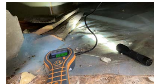
Fuktmåling i etasjeskiller i krypkjeller viste tørre verdier.
