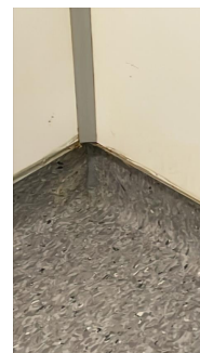
Skjøt i hjørne inne i dusj er utbedret etter befaringen.
