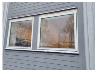
Vinduer på kjøkken og soverom
