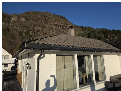
Generelt bilde av takstein.
