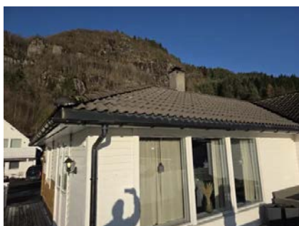
Generelt bilde av takstein.
