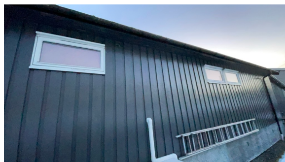
Vinduer på bad og stue
