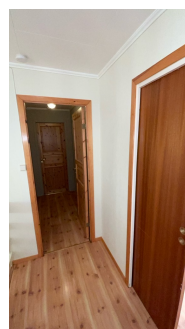
Skyvedør til kjøkken og furudører til gang, bad og soverom i 1. etasje.
