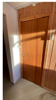
Dør til lagerrom mangler nøkkelskilt
