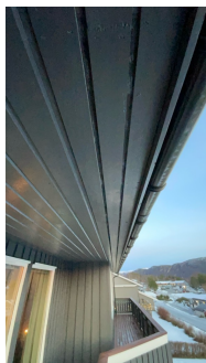
Synlig ventilering i raftekasse ved overgang tak/vegg
