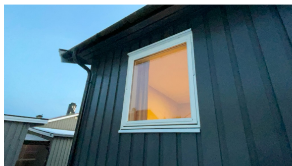
Vindu på soverom 2 fra 2006, montert 2024
