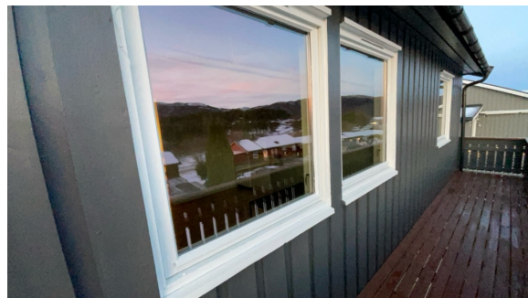
Vinduer på kjøkken og soverom
