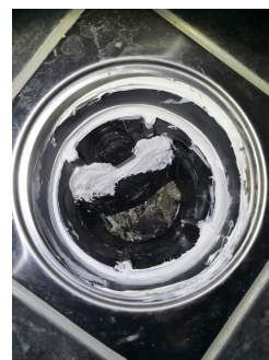
Bilde tilsendt av selger etter at det er utført ekstra sikring med tetting for å sikre bedre tetthet.
