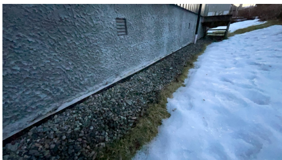
Synlig grunnmursplast på oversiden av boligen
