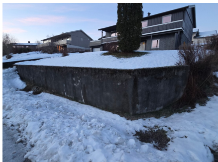
Oversikt støttemur. Her bør det monteres rekkverk
