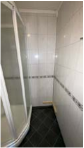
På siden av dusjkabinett er det plass for høyskap. Selger har demontert det for tilkomst til sluk under dusjkabinett.
