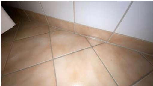
Sprekker i 3 fliser på vegg av samme type som gulvet.
