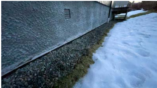
Synlig grunnmursplast på oversiden av boligen
