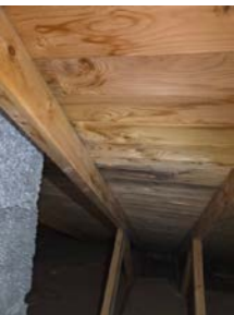
Eldre fuktmerker ved pipe. Ingen fukt på befaringsdagen
