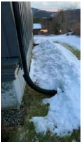
Takvann på tak over veranda er ført til terreng
