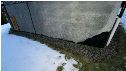
Synlig grunnmursplast på siden av boligen
