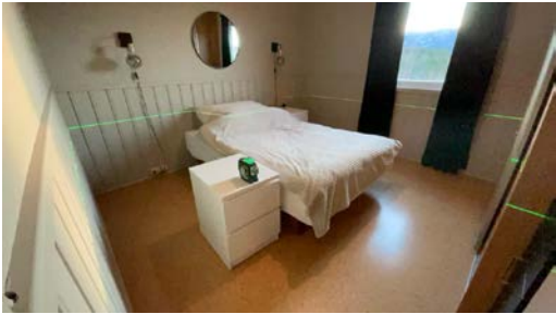
1. etasje Plassering av laser ved kontroll av soverom 1. Det er målt 6 mm høydeforskjell gjennom rommet. TG 1
