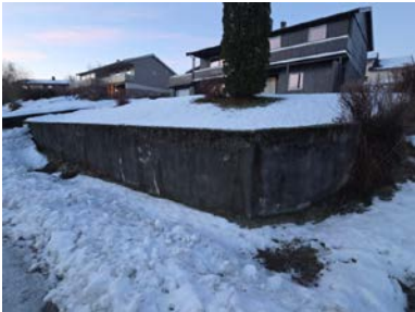
Oversikt støttemur. Her bør det monteres rekkverk
