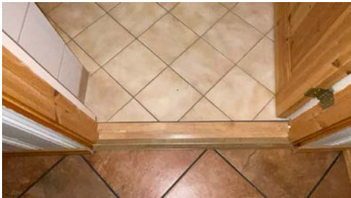
Standard dørterskel uten tilluft
