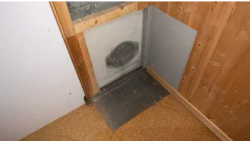
Montert brannsikker plate i sotluke for å ivareta krav til brannsikkerheten. I tillegg er det montert plater på gulv og vegg
