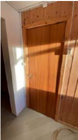
Dør til lagerrom mangler nøkkelskilt
