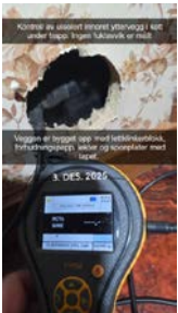
Kontroll av innforet yttervegg i kott under trapp. Ingen fuktavvik er målt. Vegg er bygget opp med lettklinkerblokk, lekter og sponplater med tapet.
