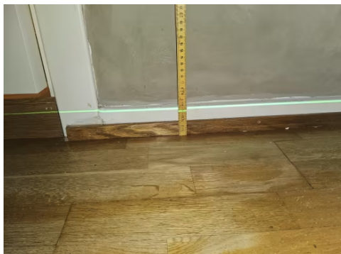
Etasjeskille er kontrollert med nivelleringslaser.
