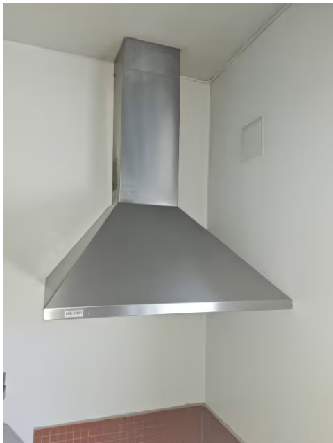
Det er etablert kullfilterventilator over komfyr.
