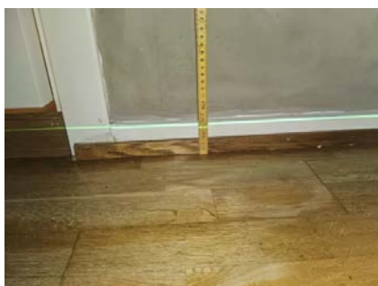
Etasjeskille er kontrollert med nivelleringslaser.
