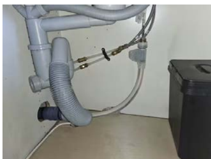
Leiligheten har synlige avløpsrør av plast.
