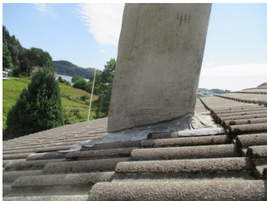
Bunnbeslag på pipe over tak.
