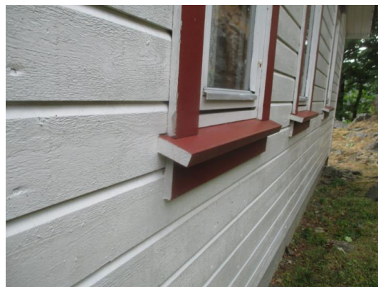
Deler av kledningen med tilhørende belistninger.
