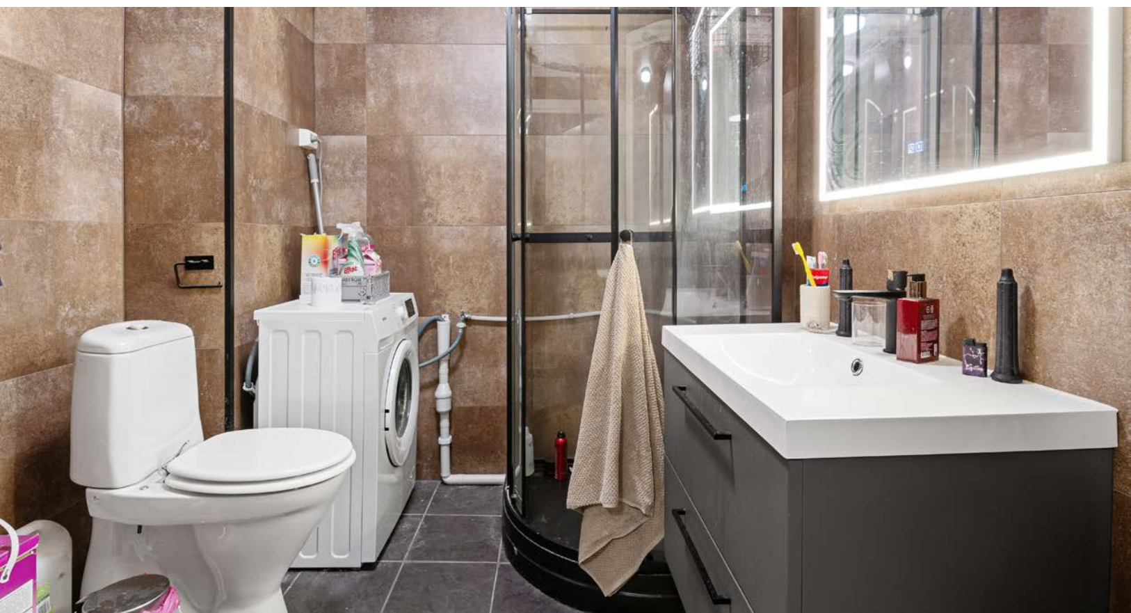
Badet/vaskerom i 1. etasje har baderomsplater på vegg og vinylbelegg på gulv (ikke godkjent). Det er utstyrt med toalett, nedfelt vask i skuffeseksjon, dusjkabinett og uttak for vaskemaskin.
