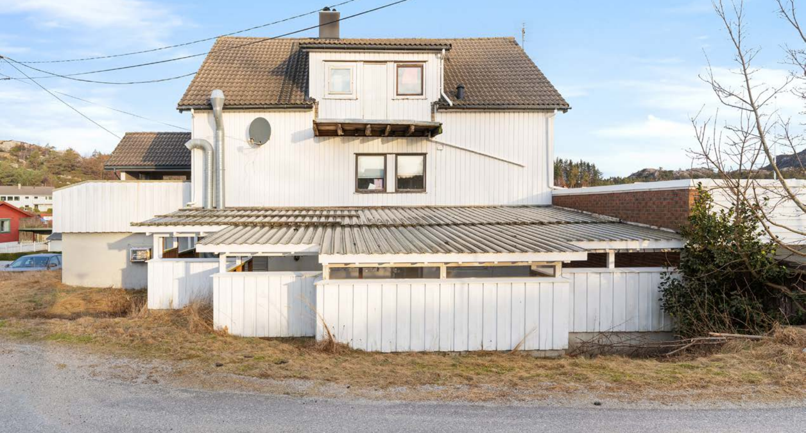
Eiendommen ligger sentralt ved Jærveien på Hellvik i Egersund kommune.
