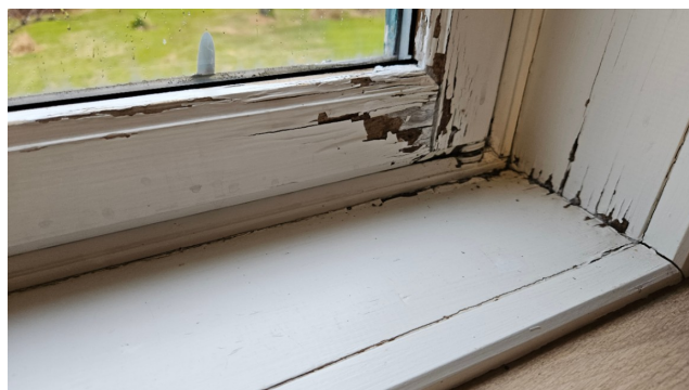
Eksempel på vinduskarm.
