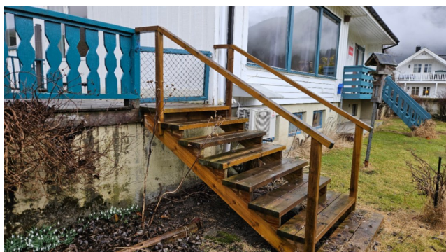
Nyere trapp med håndrekker.
