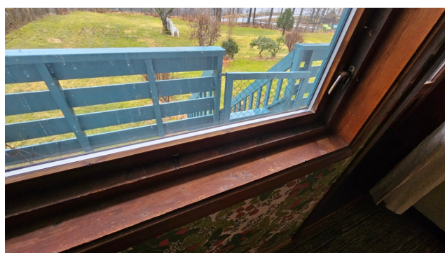
Eksempel på vinduskarm.
