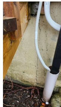
Bilder viser eksempler på sprekker og riss.
