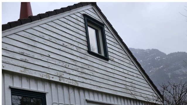
Bildet viser værslitt gavl mot vest.
