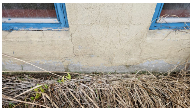
Bilder viser eksempler på sprekker og riss.
