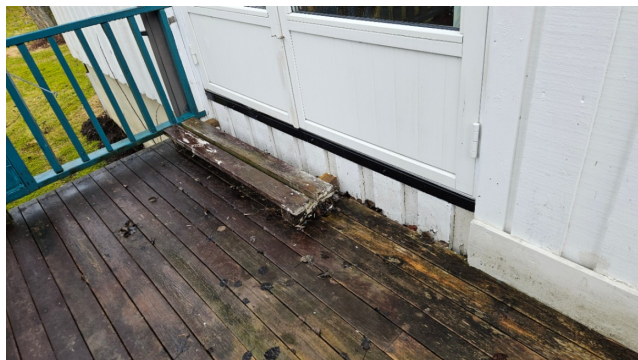
Bildet viser ett høyt opptrinn med enkelt trinn.
