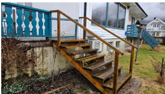
Nyere trapp med håndrekker.
