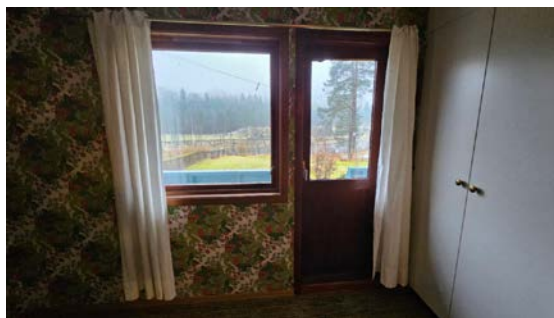
Terrassedør fra byggeår
