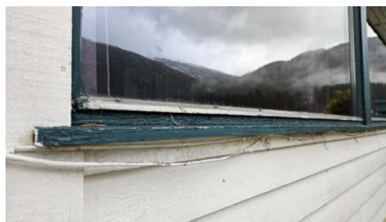
Bildet viser karmen og vannbord med slitasje.
