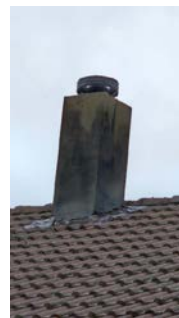
Det er ikke montert pipebeslag.
