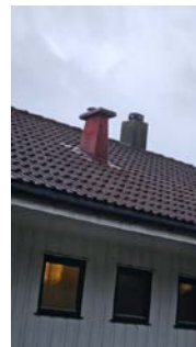
Det er ikke montert pipebeslag.
