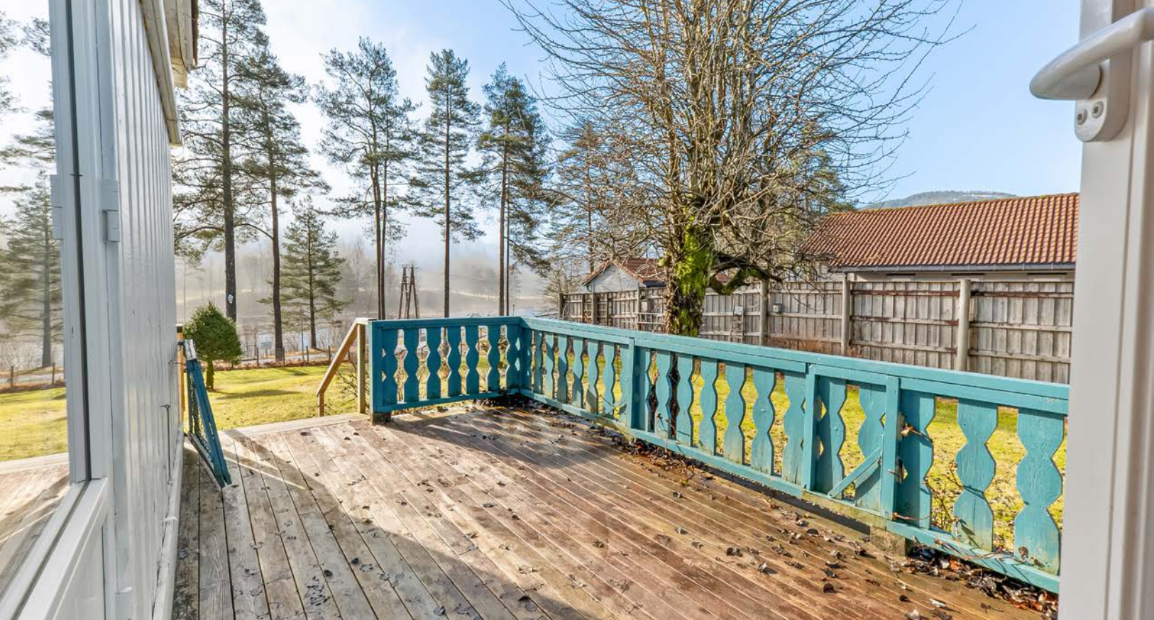
Fra stue er det utgang til usjenert terrasse.
