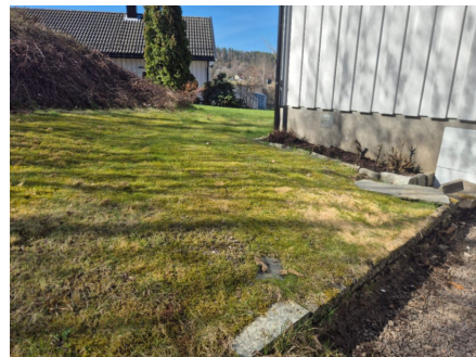
Terrengheller mot grunnmur til krypkjeller.
