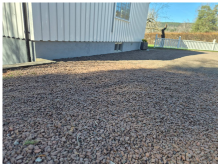
Terrengheller mot grunnmur.
