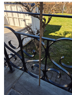
Lavt rekkverk og store åpninger.
