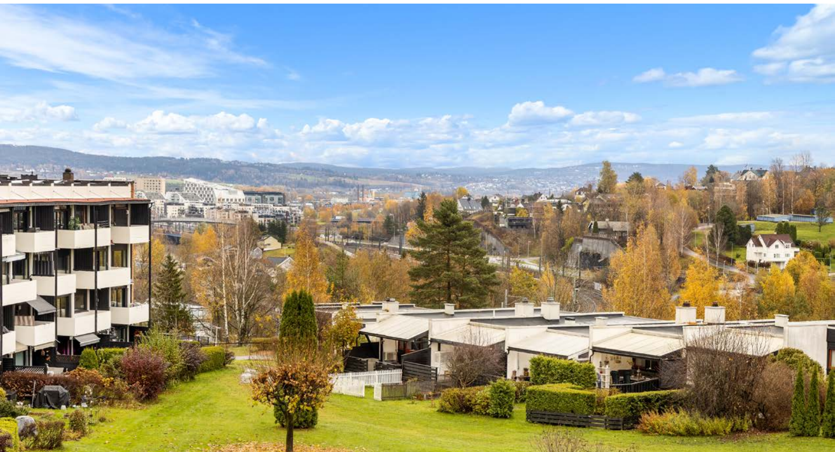
Fellestomten er pent opparbeidet med store plenarealer, vakre prydbusker og asfalterte internveier.
