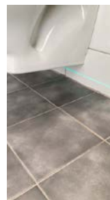
Det er ikke påvist tilfredsstillende løsning for å synliggjøre lekkasje fra innebygget sistene.
